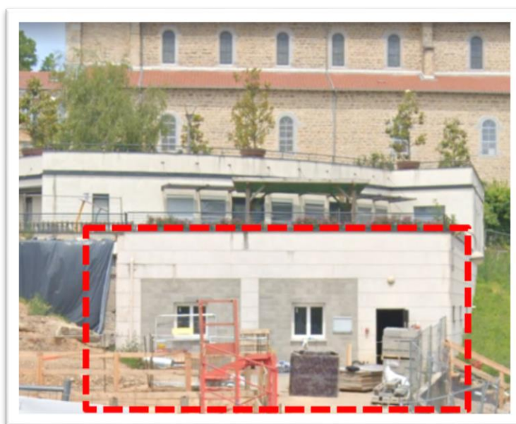
Localisation de l'ancien CTM
